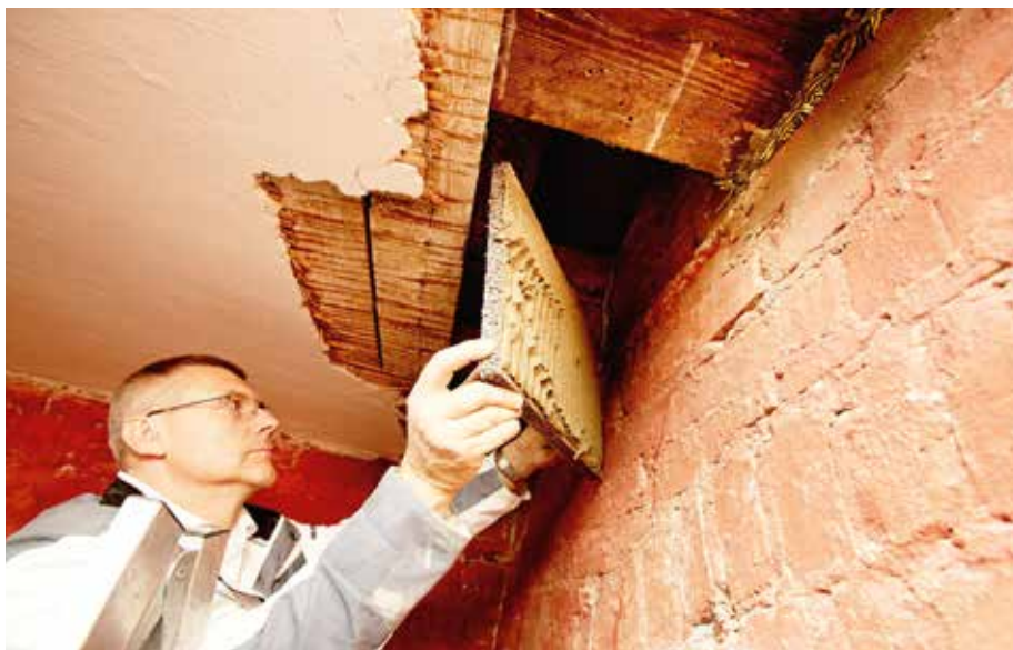
Die in die Gefache zwischen die Holzbalken eingelegte Rigips-Thermo-Platte sorgt dank ihres exakt auf das Gesamtsystem abgestimmten sd-Werts für einen konstruktiven Schutz der Holzbalken.
