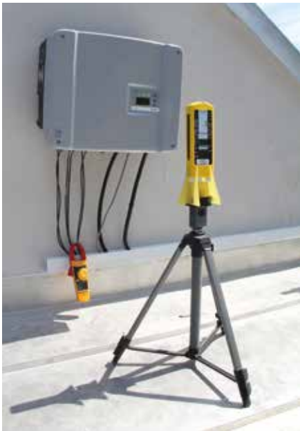
Eines der vielen baubiologische Details: Der Wechselrichter der Solaranlage ist strahlungsarm und steht weit weg von Daueraufenthaltsplätzen. Alle Kabel sind geerdet, die Anlage wurde messtechnisch überprüft.
