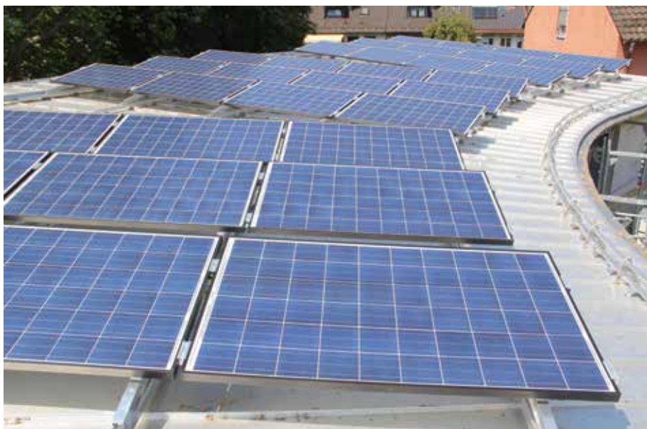
Mit der Fotovoltaikanlage auf dem Dach sollen pro Jahr zirka 7500 Kilowattstunden Strom gewonnen werden, fast doppelt so viel, wie das Gebäude verbraucht.
