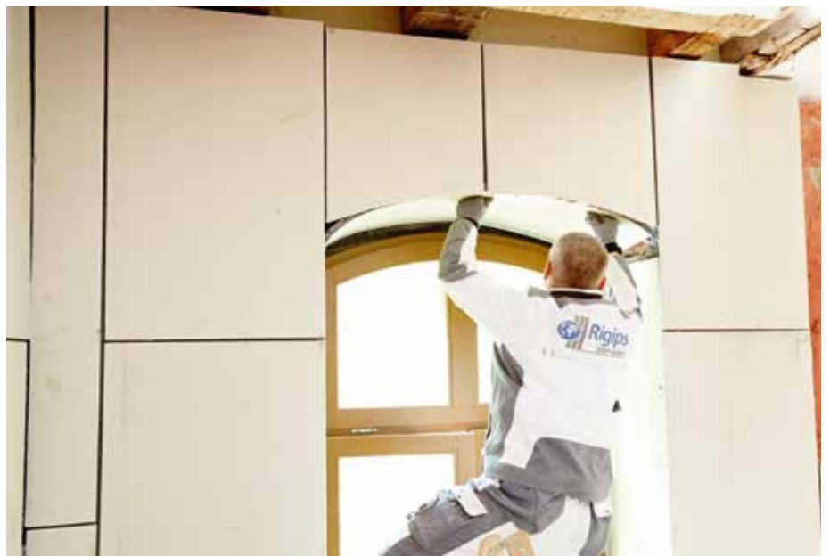
Auch bei den Fensterrundbögen in diversen Radien konnten die schlanken Rigi-Thermo-Platten angepasst und verarbeitet werden.
