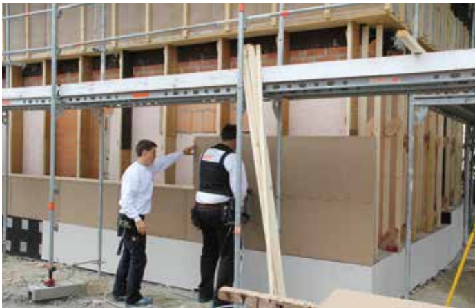
Der alte, eingeschossige Massivbau erhielt ein WDVS komplett aus nachwachsendem Holz.
