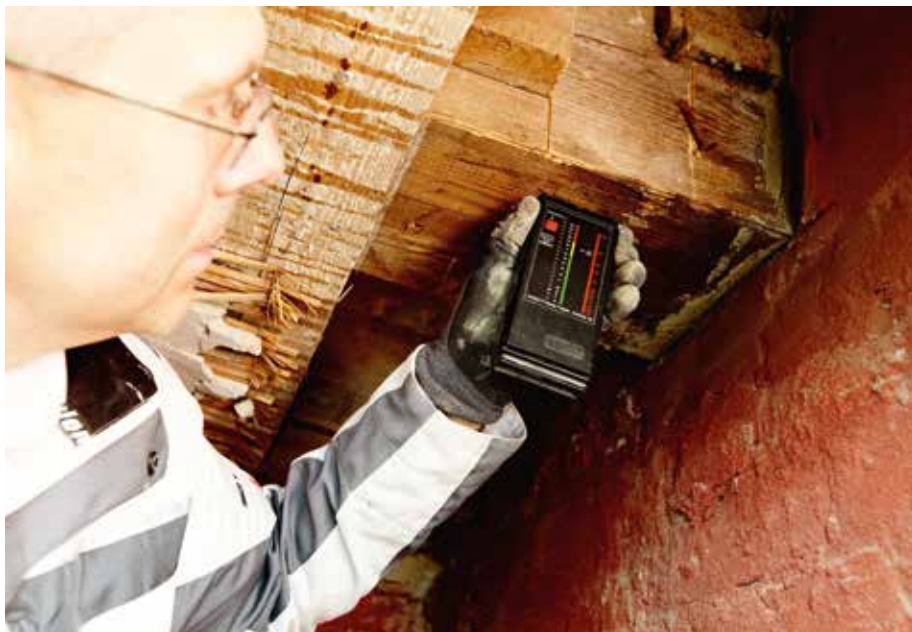
Trockene Holzbalken in gutem Zustand: Die Holzfeuchtemessung ergab einen Feuchtegehalt von weit unter den maximal zulässigen 20 Masseprozent.
