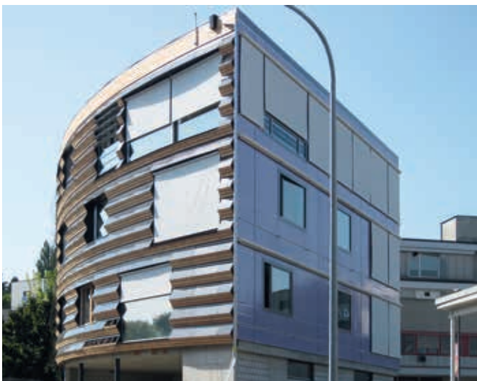
In die Südfassade ist Photovoltaik integriert, die Nordostfassade besteht aus transluzenter Wärmedämmung.
